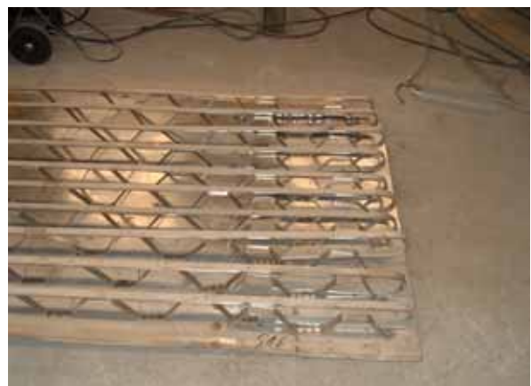
Cage de ferrailage avec peau continue Inox pour réservoir étanche
