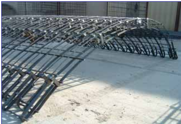
Cage de ferraille en aciers plats pour voûte de « Conduits MATIERE »
