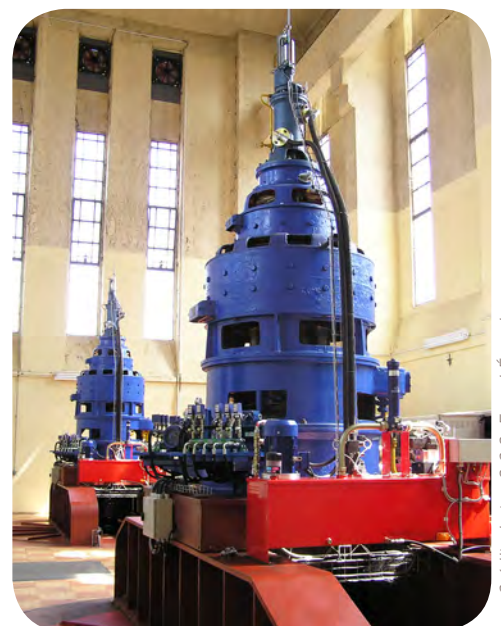
Les deux groupes alternateurs de la centrale de Fumel.
